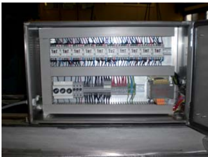
Bild links: Kranschaltschrank in Edelstahl mit Schützsteuerung.
